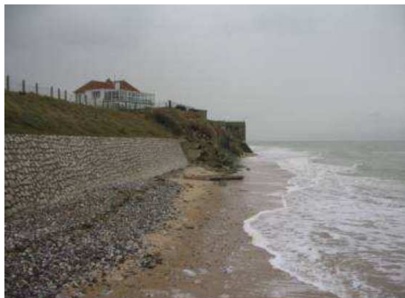
vue de l'objet estran en pied de l'ouvrage
